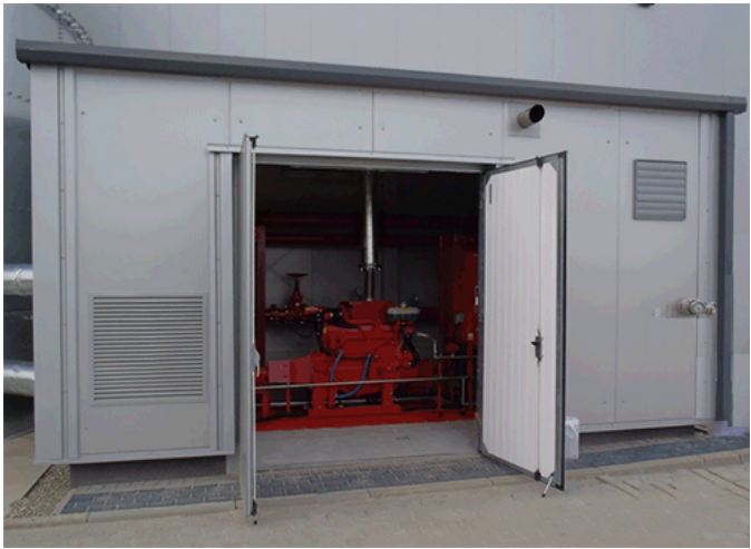
КОНТЕЙНЕРНОЕ ИСПОЛНЕНИЕ НАСОСНОЙ СТАНЦИИ ПОЖАРОТУШЕНИЯ ДЛЯ МОНТАЖА «НА УЛИЦЕ»
